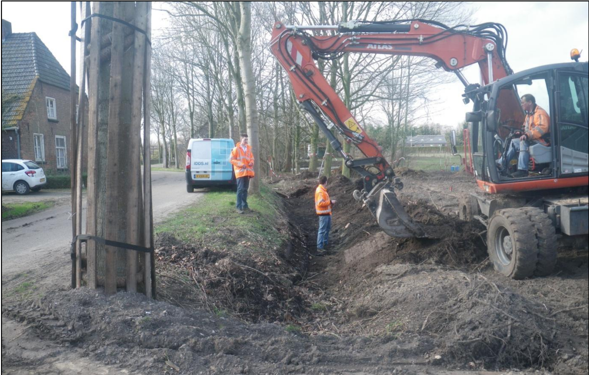
Figuur 4: WP5 werd uitgediept met een dichte bak met een gladde rand.
