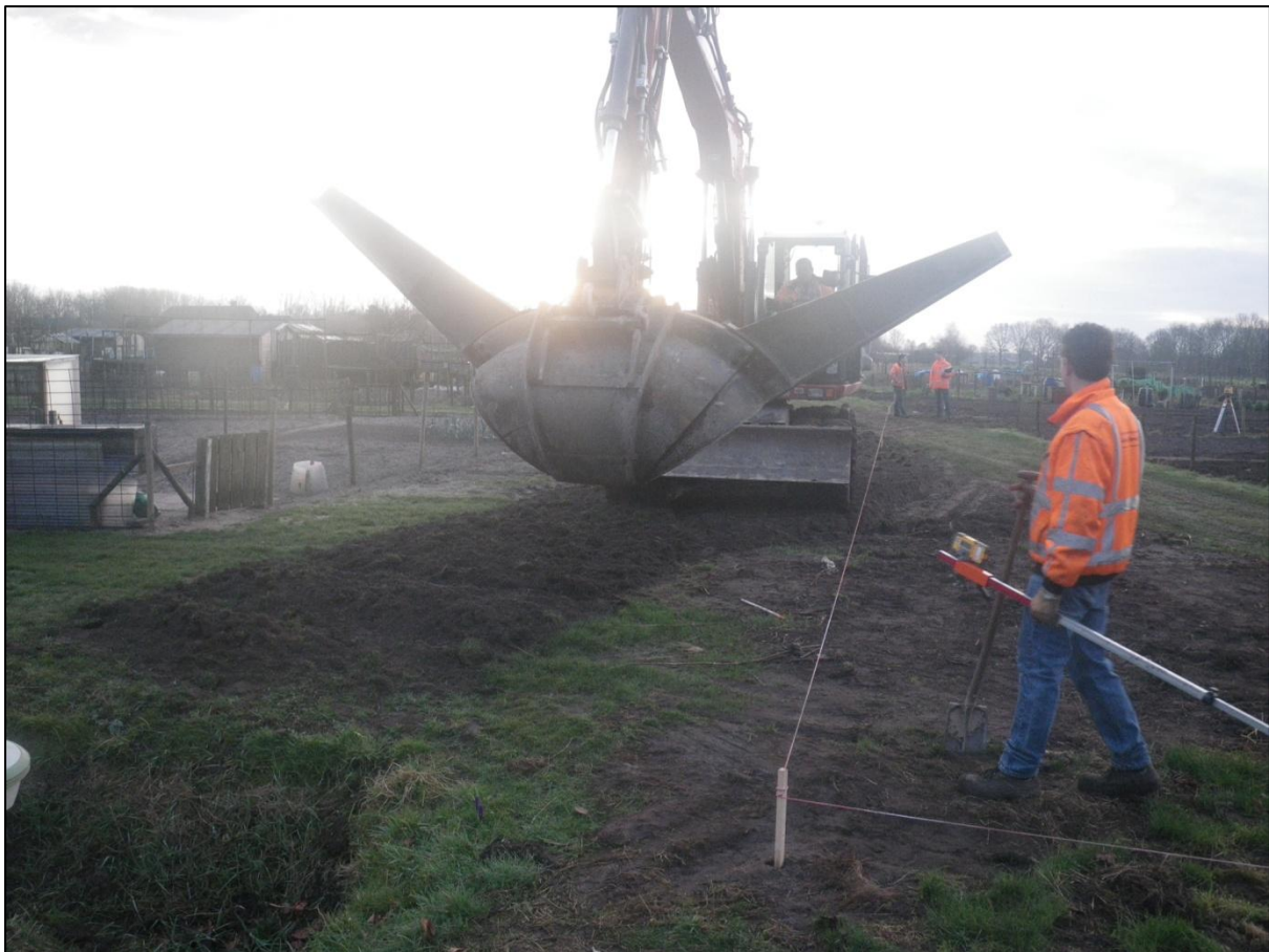
Figuur 3: De graafwerkzaamheden in WP1 tot en met WP4 zijn uitgevoerd met een V-bak.
